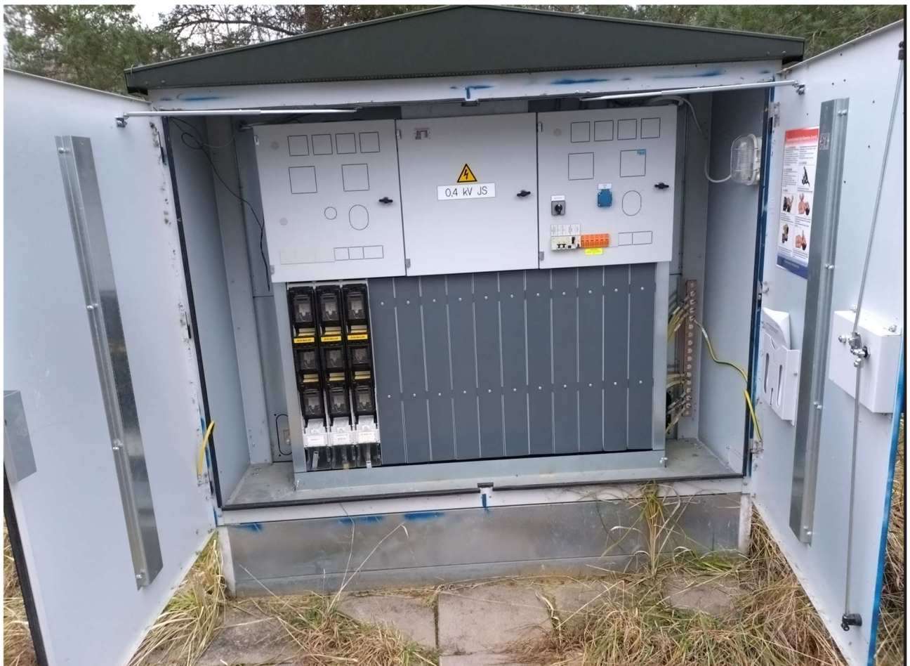
Joonis 3.1 – Alajaama Silbet puhkebaas 0,4 kV jaotusseade.
